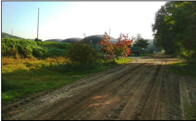
Angrenzender Wirtschaftsweg südwestlich der Biogasanlage, Blickrichtung Ost
