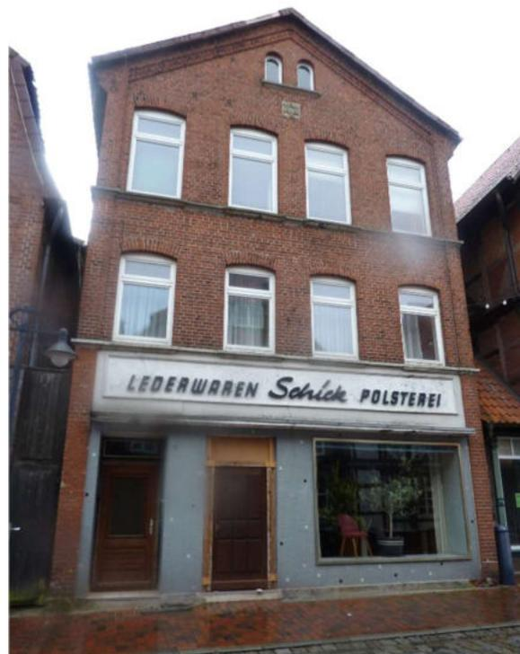
Lange Straße 6, Überprägung der Fassade, Aufhebung der kleinteiligen Fassadenstruktur durch vergrößertes Schaufenster, Sonnenschutzanlagen
