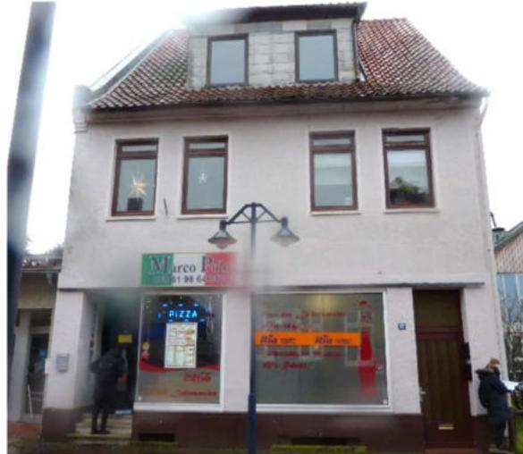
Mühlentor 12, verputztes Sichtmauerwerksgebäude, nachträglich eingefügte Dachgaube und vergrößerte Schaufenster
