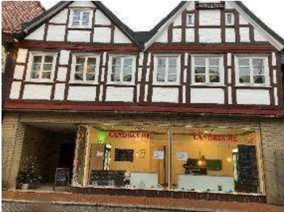
Marschorstraße 7, Aufhebung der kleinteiligen Fasadensstruktur durch vergrößertes Schaufenster und Überprägung der Fassade
